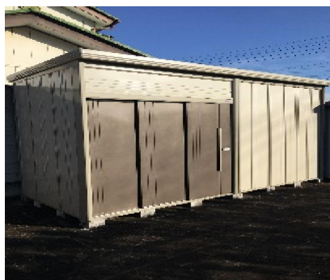
ユニット型特養課中庭に設置した物置(非常食等保管用)
